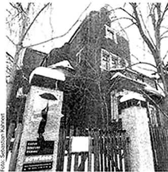
Das Gebäude des Frauenzentrums befindet sich in einem schlechten Zustand.
